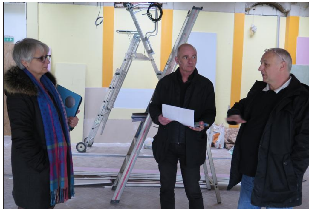
■ Les travaux ont débuté mi-septembre avant une montée en puissance à partir de fin octobre dernier.
